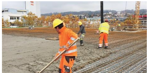
Chapes sur bacs acier autoporteurs ou non (réduction jusqu'à 30% des aciers). La classe de résistance dépend du type de bacs.
