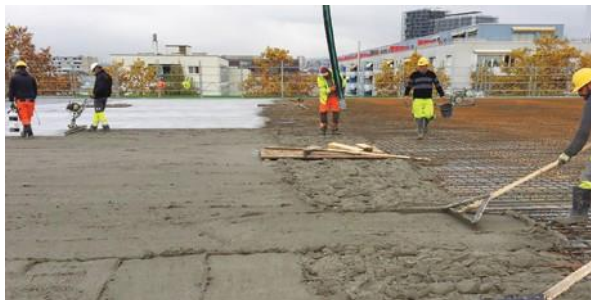
Forme de pente sur toitures et terrasses accessibles ou non, jusqu'à 10% de pente la masse volumique dépend du support et du type d'étanchéité.
