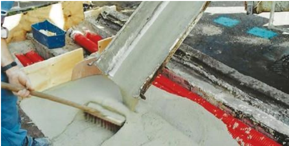
Isolation de canalisations ( \lambda=0.065 ) béton D0.3 facilement excavable.
